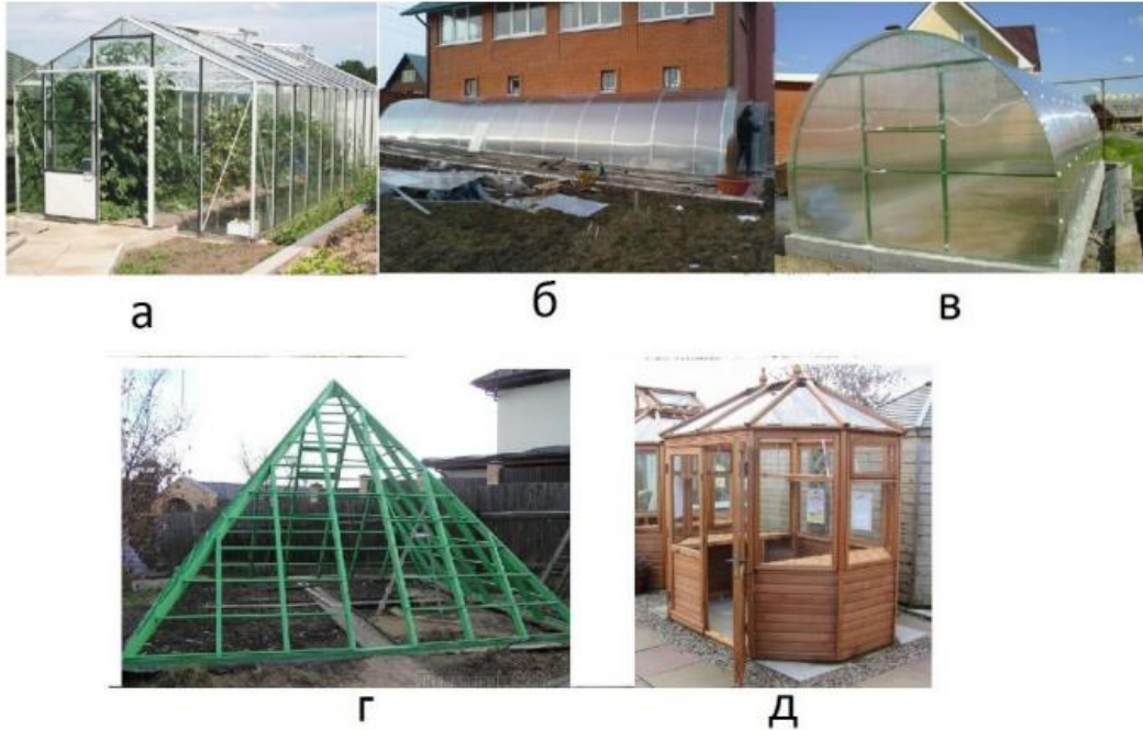
а) тікбұрышты, ә) қабырғаға орнатылған, в) арка тәрізді, г) пирамидалы жылыжай, д) көпбұрышты ағаштан жасалған 1.2 Сурет - Жылыжайдың конструкторлық типтері
